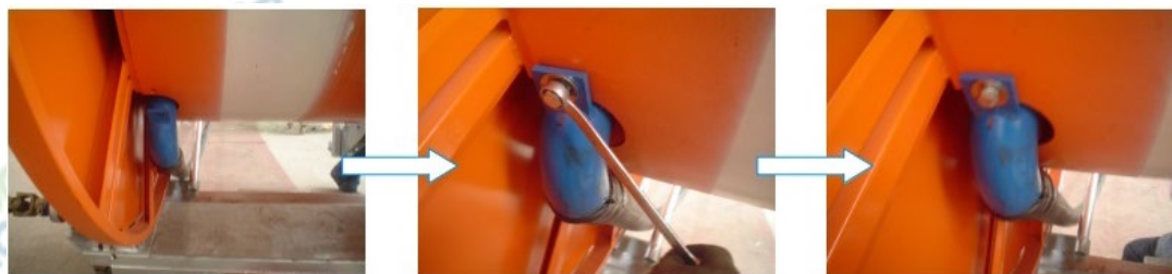
安装出水弯头
